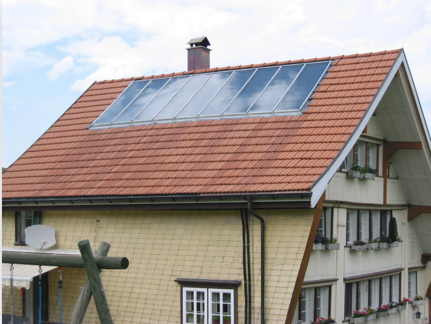
Bisheriger Einsatz in der Schweiz: eher kleinere Anlagen für Warmwasser in Wohnbauten
