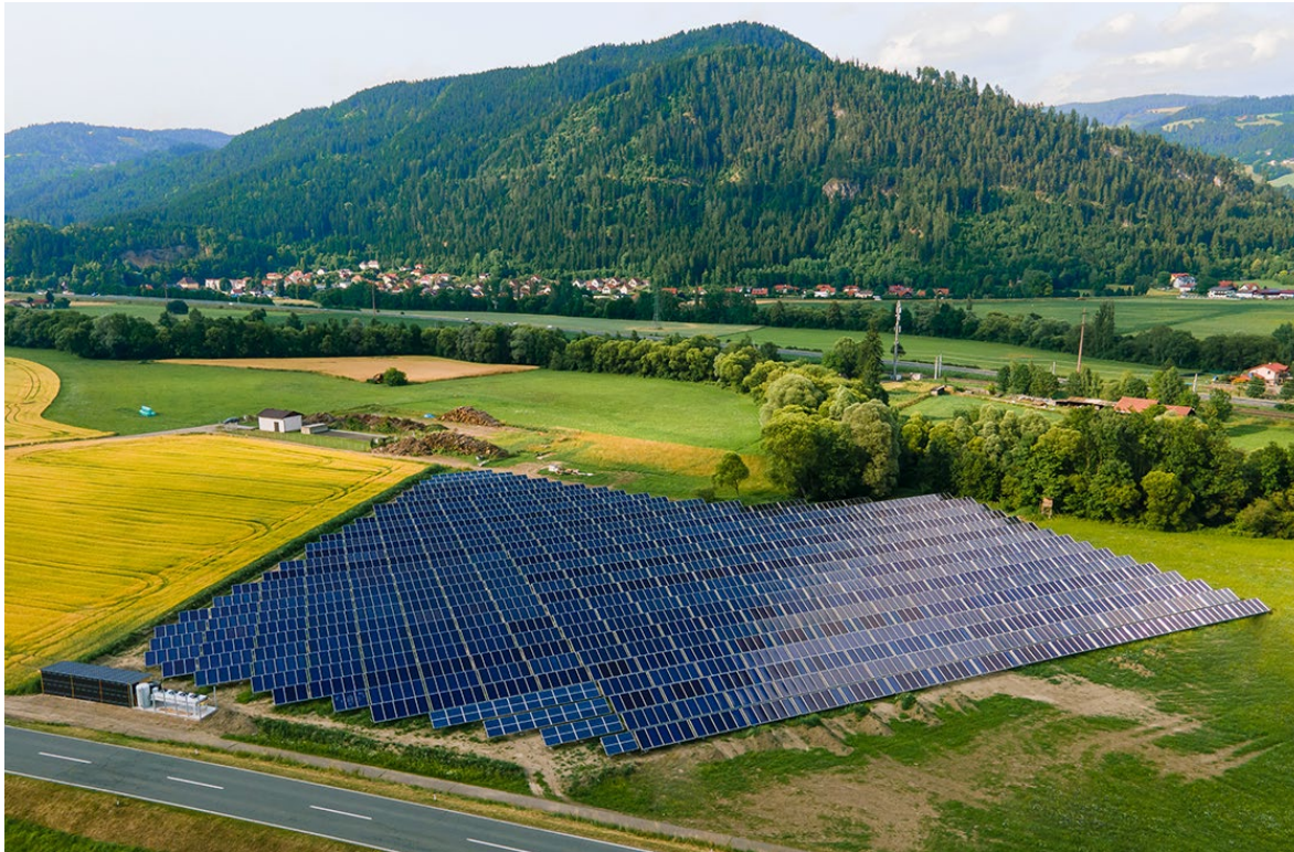
Fernwärme Friesach, Kärnten (AT), 4 MW © Austria Solar
